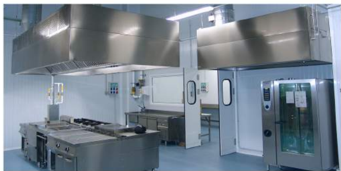
Campanas Extractoras Beret y Horno
