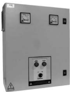
Cuadro eléctrico para arranque con amperímetro y voltímetro
