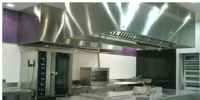
Campanas Extractoras Vilak y Horno
